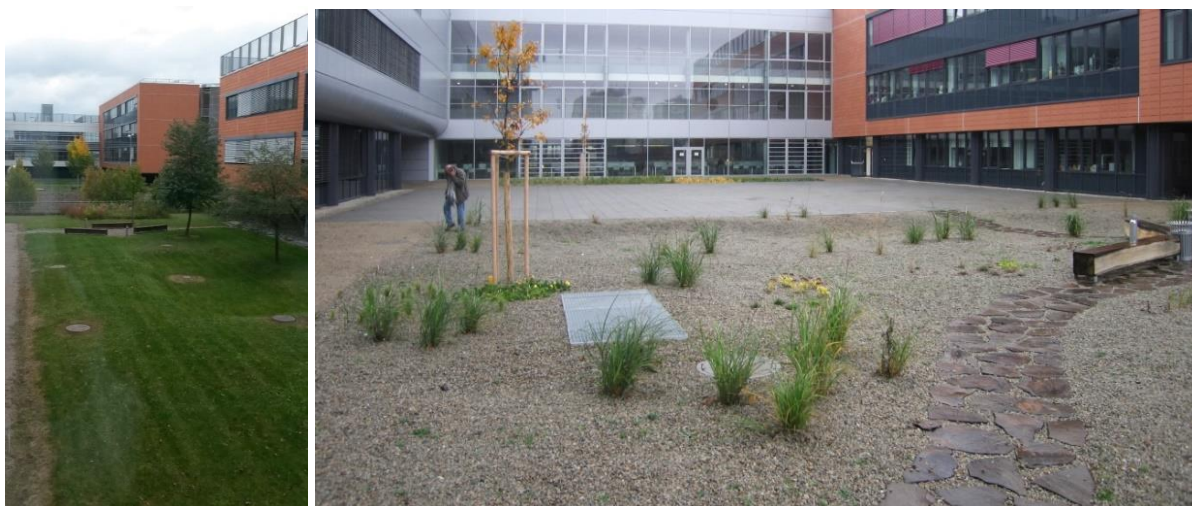
Obr. P31. Vsakovací průlehy s retenčními rýhami mezi pavilony kampusu Masarykovy univerzity v Brně-Bohunicích (vlevo) a v Akademicko výzkumném a vývojovém areálu (vpravo) (Foto: I. Kabelková a JV PROJEKT VH s.r.o.)
