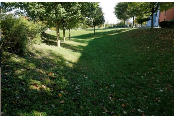
Obr. P5. Soukromá parkovací stání v solarCity mívají poškozenou zatravnňovací vrstvu (vlevo), a proto je dešťová voda z nich ještě odváděna do průlehů (vpravo) (Foto J. Vítek)
