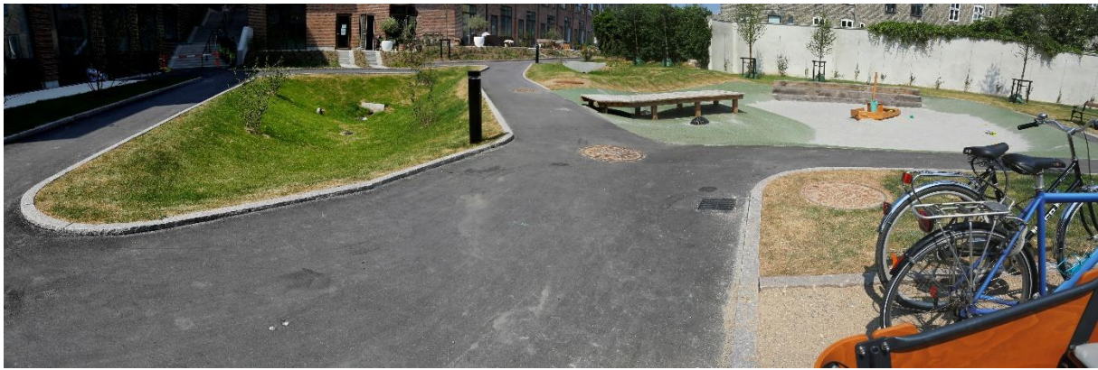
Obr. P13. Průleh a dětské hřiště pro retenci srážkové vody v Carlsberg City v Kodani (Foto J. Vítek)
