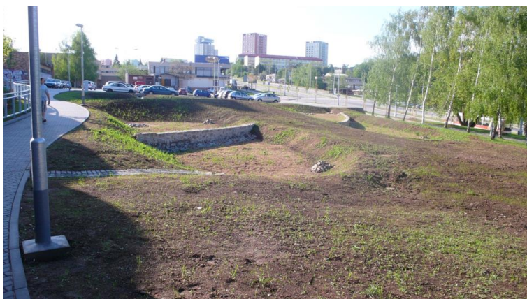
Obr. P34. Průlehy v areálu Aquaparku Brno-Kohoutovice (uprostřed průlehu je bezpečnostní přeliv do retenční rýhy) (Foto: JV PROJEKT VH s.r.o.)
