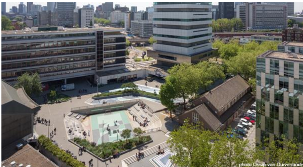
Obr. P29. Vodní náměstí Bentheplein v Rotterdamu (Foto: O. van Duivenbode)
