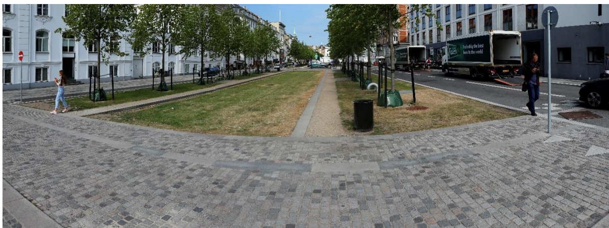
Obr. P11. Náměstí Sankt Annæ Plads v Kodani umožňuje po prohloubení retenci vody (Foto J. Vítek)
