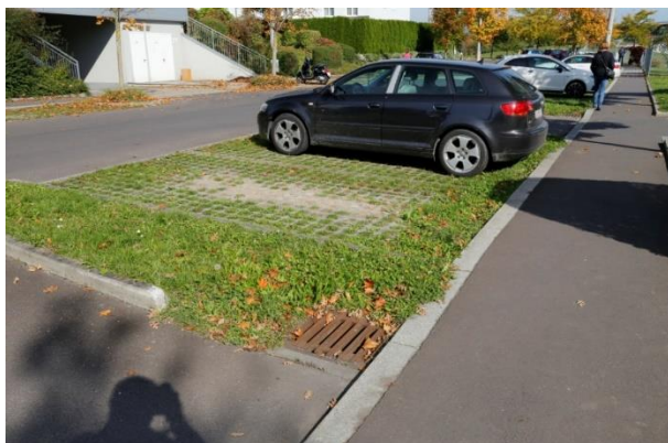
Obr. P5. Soukromá parkovací stání v solarCity mívají poškozenou zatravnňovací vrstvu (vlevo), a proto je dešťová voda z nich ještě odváděna do průlehů (vpravo) (Foto J. Vítek)
