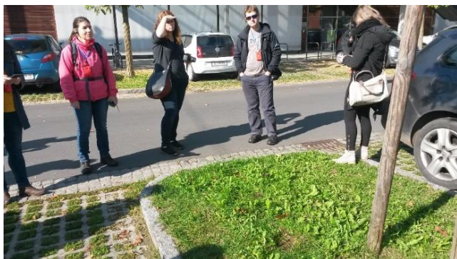
Obr. P2. Veřejné parkovací stání v solarCity se zatravnňovacími tvárniciemi položenými 30 cm humusové vrstvě a odtokem do šachty a drenážního potrubí a následně do vsakovací nádrže (Foto I. Kabelková)
