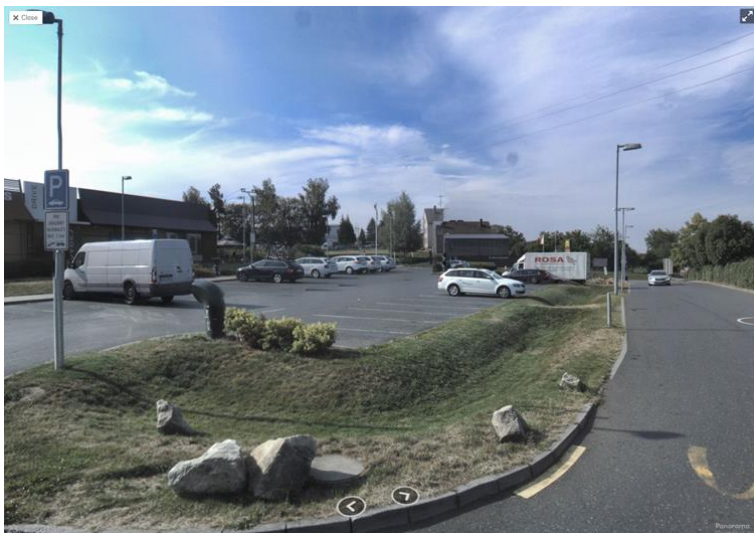
Obr. P35. Odvodnění parkoviště a komunikace u McDonald's sníženými obrubníky do průlehu
