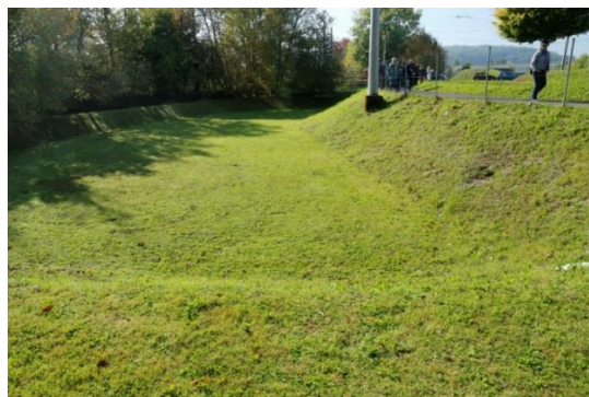
Obr. P3. Vsakovací nádrž v solarCity se při velkých přívalových deštích může přelít do potoka na levé straně (Foto J. Vítek)
