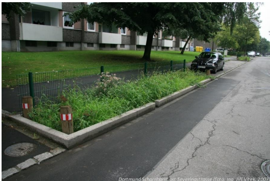
Obr. P25. Umělý biotop s přívodem srážkového odtoku z komunikace v Dortmundu (Foto: J. Vitek)
