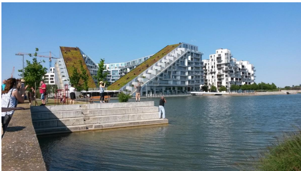
Obr. P15. Dešťové jezero v Ørestadu (Foto I. Kabelková)
