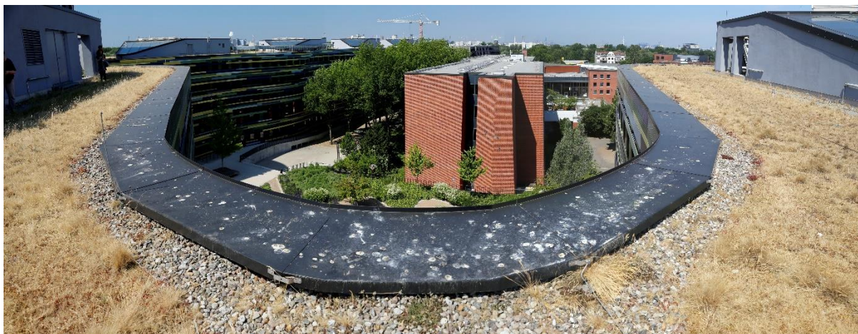
Obr. P16. Pohled z extenzivní střešů budovy Úřadu pro městský rozvoj a životní prostředí v Hamburku na střešní zahrady na podzemních garážích (Foto J. Vitek)
